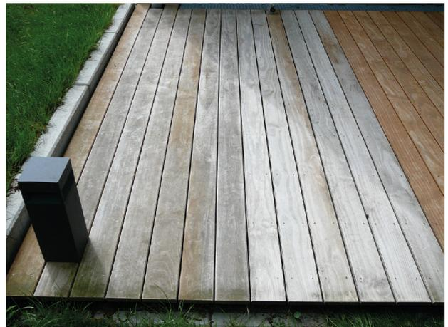
**Abb. 6:** Holzbelag ohne Oberflächenbehandlung mit intensivem mikrobiellen Belag (linke Hälfte) und nach der Reinigung (rechte Hälfte)
