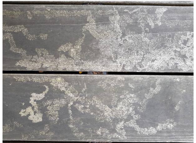
**Abb. 4:** Fraßspuren von Schnecken auf Belagsdielen mit intensivem Bewuchs von Holzverfärbenden Pilzen und Algen
