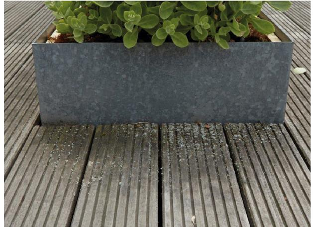
**Abb. 2:** Algen- und Flechtenbewuchs im beschatteten Bereich (verringerte Abtrocknung → höhere Feuchte)
