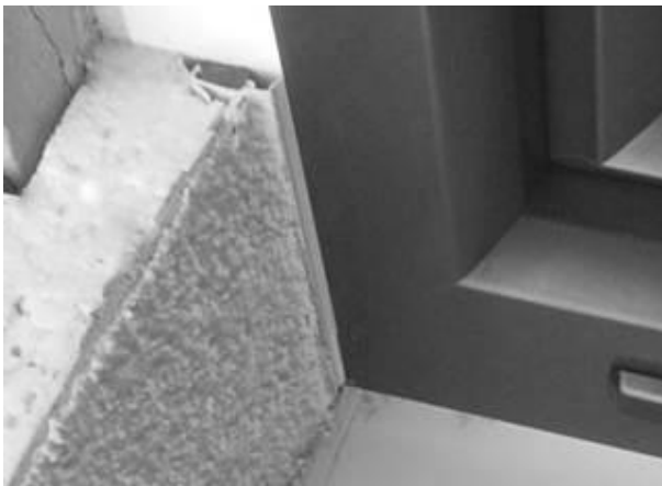
Abbildung 20: Fenster mit Vorsatzschale als Halbschale ausgeführt
