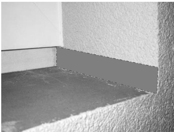
Abbildung 26 Zweite wasserführende Ebene mittels beschichtetem Parapetes (Dichtschlämme inkl. seitlich überputztem Hochzug - schematisch dargestellt unter Oberputz)
