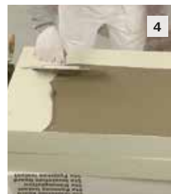
4 Verarbeiter-Tipp: Sto-Sockelplatte EPS-S zusätzlich vollflächig mit StoFlexyl abspachteln (erhöhter Haftverbund).
