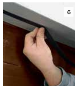
6 Kurz vor Verlegung der Sockeldämmung auf der Unterseite des Sockelprofils das Sto-Fugendichtband Lento aufkleben. Auf korrekte Lage des Fugendichtbandes achten (projektierte Vorderkante Sockelplatte).
