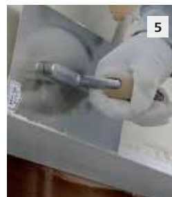
5 Anschließend Sockelprofil mit gelochtem Schenkel und integriertem Gewebestreifen in den noch feuchten Unterputz einbetten. Flächenbewehrung wie auf Seite 16 beschrieben durchführen.
