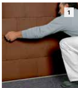
1 Sockelhöhe festlegen und anzeichnen. Die Unterkante der Sockelleiste muss mind. 30 cm* über der Gelände- bzw. Belagsoberkante liegen. Anschließend den Sockelbereich mit StoFlexyl vorstreichen, 1:1 mit Zement vermischt und mit 10% Wasser verdünnt.
