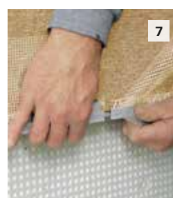
7 Das Sto-Sockelprofil PH verfügt über vormontierte Steckverbinder. Im Stoßbereich überlappt zusätzlich der werkseitige Gewebeüberstand des Sockelprofils. Abhängig von der objektspezifischen Einbausituation optional Sto-Sockelleistenverbinder L einbauen. Die Verbinder sollten so lang sein, wie die Unterseite des Sockelprofils breit.
