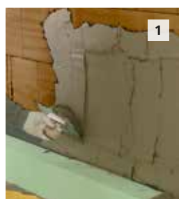
1 Den Sockelbereich ca. 30 - 50 cm über Geländeoberkante mit StoFlexyl vorstreichen, 1:1 mit Zement vermisch und mit 10 % Wasser verdünnt. Trockenzeiten beachten.
