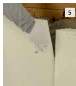
5 Nach dem Andrücken der Dämmplatte muss die Kleber-Kontaktfläche, gemessen am Untergrund, mindestens 80 % betragen.
