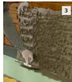
3 Baueits vorhandene Sockeldämmplatte (Perimeterdämmplatte) mit StoFlexyl stirnseitig abspachteln und anschließend zupfen.
