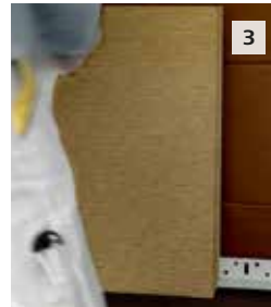
3 Erste Dämmplattenreihe auf das Startprofil aufsetzen (siehe Seite 13).
