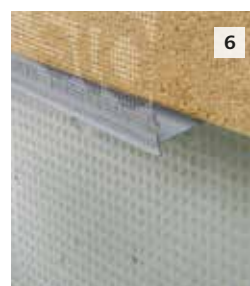
6 Nach Verlegung der Fassadendämmung das Sto-Sockelprofil PH in die Fuge zwischen Sockel- und Fassadendämmung einschieben.
